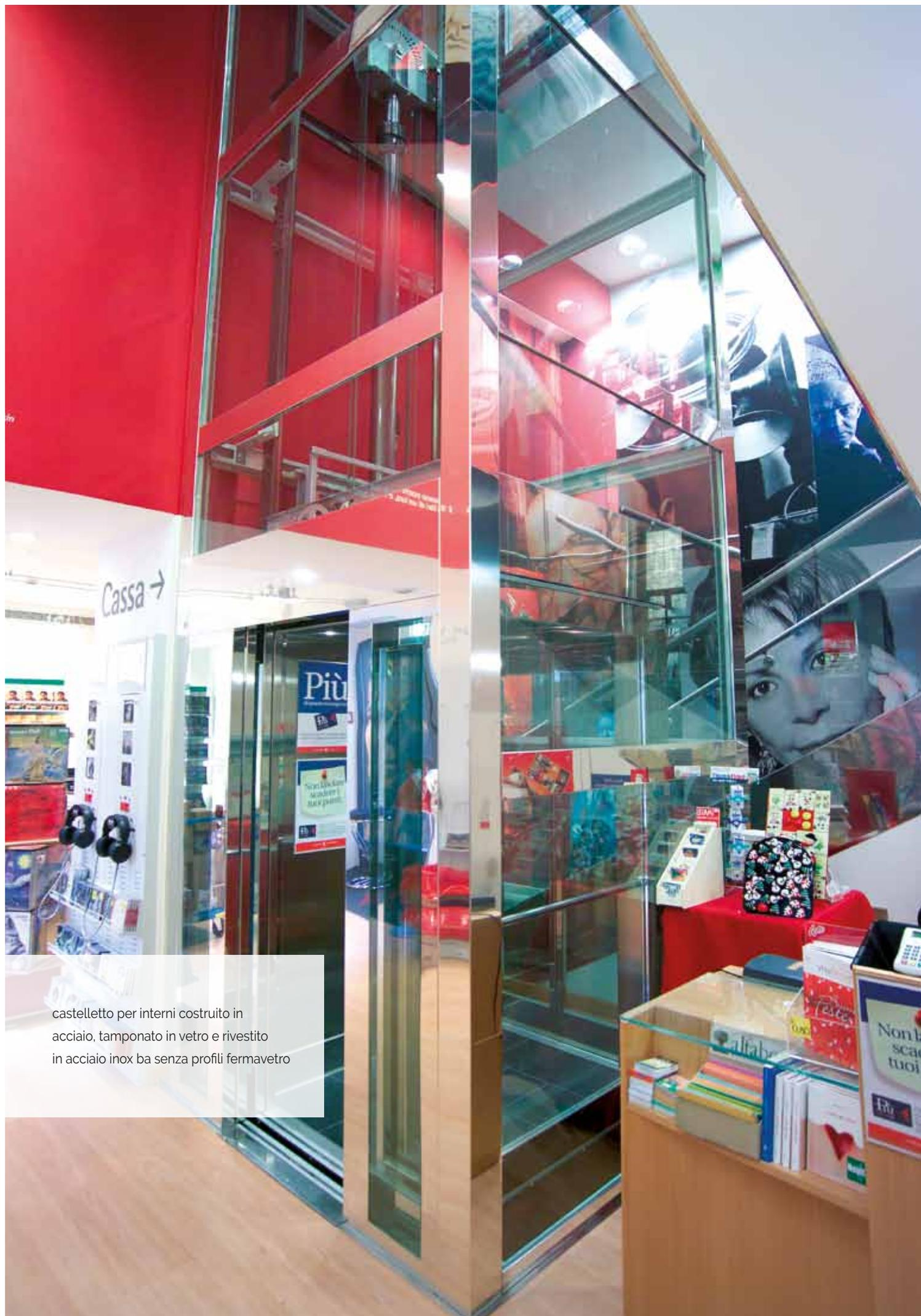
castelletto per interni costruito in acciaio, tamponato in vetro e rivestito in acciaio inox ba senza profili fermavetro
