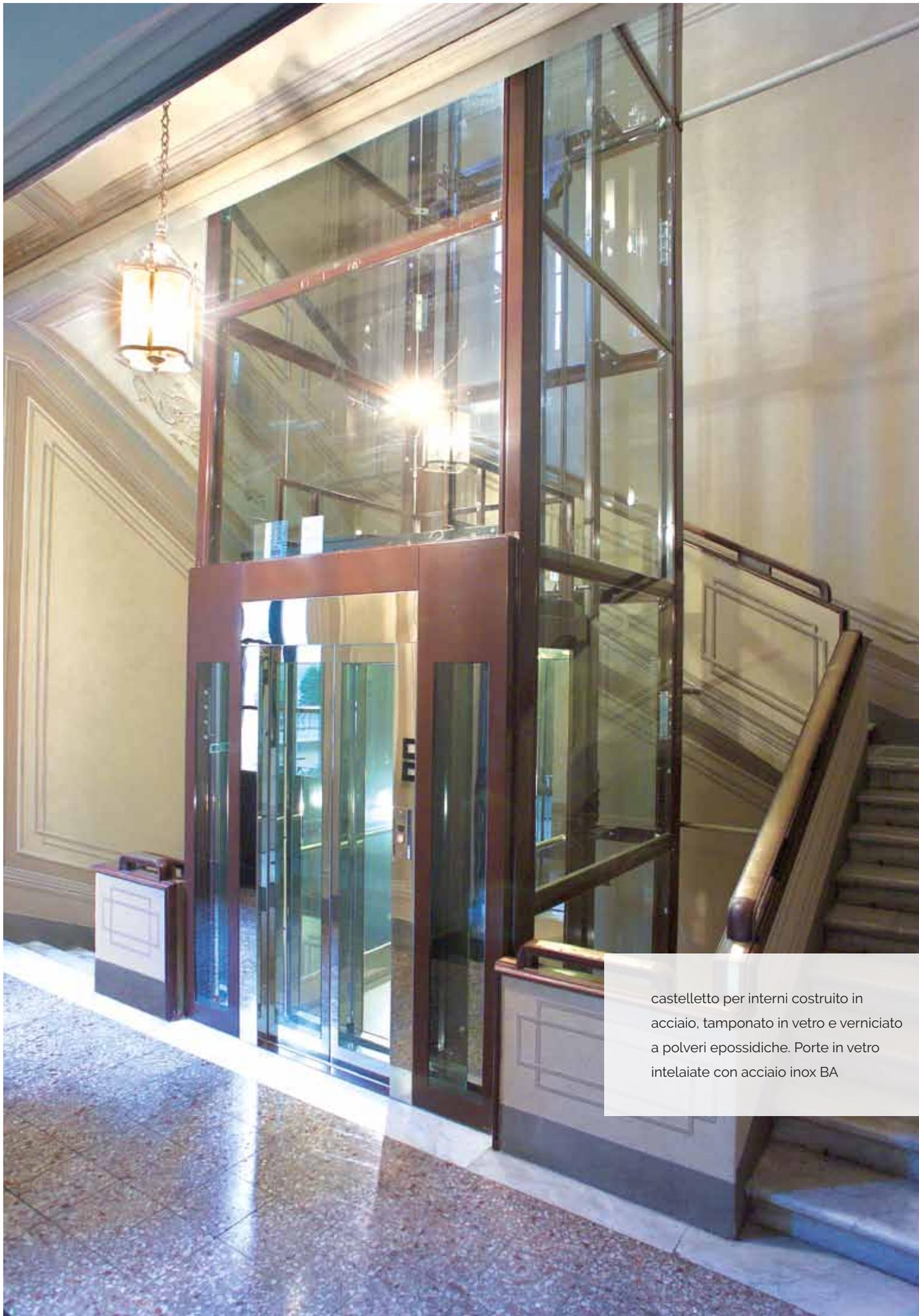
castelletto per interni costruito in acciaio, tamponato in vetro e verniciato a polveri epossidiche. Porte in vetro intelaiate con acciaio inox BA
