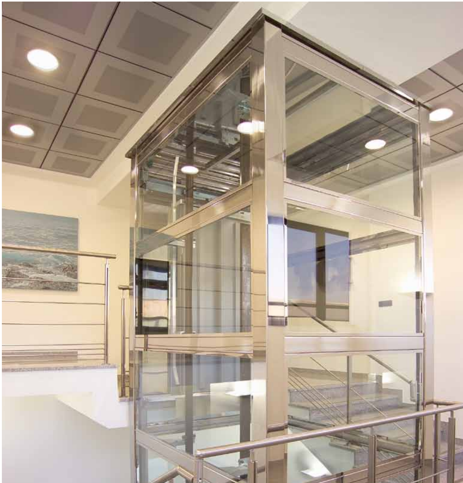
castelletto in acciaio inox tamponato in vetro
